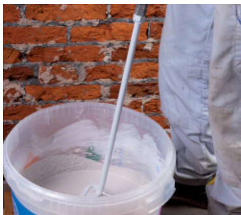
Prepararea Mape-Antique Rinzafo
