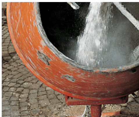
Amestecarea mortarului in situ cu agregate de provenienta locala
