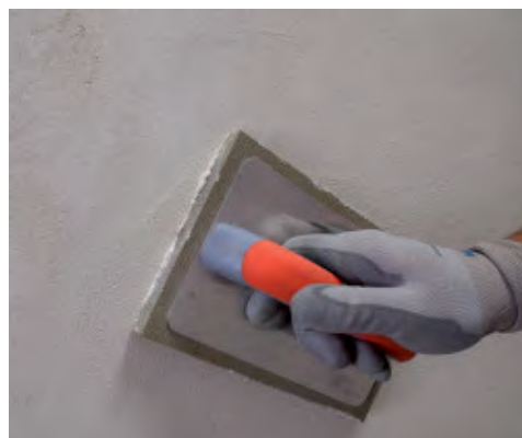
Finisarea cu o drisca de burete umed de Mape-Antique FC Civile
