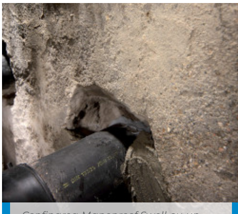
Confinarea Mapeproof Swell cu un produs din gama Mapegrout
