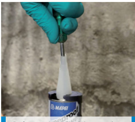
Perforarea membranei de protecție de pe tubul Mapeproof Swell
