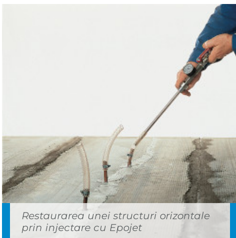
Fixarea tuburilor (injectoarelor) cu Adesilex PG1
