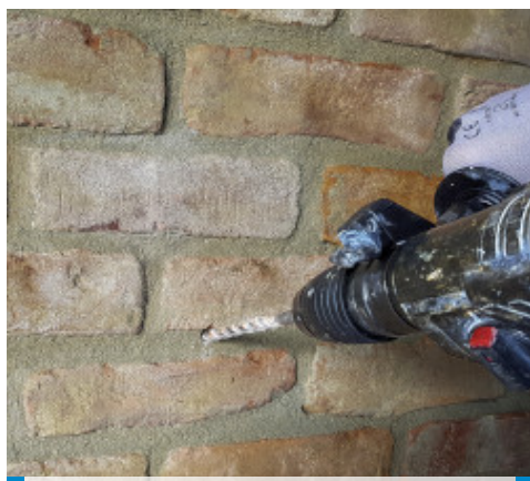
Realizarea unei serii de gauri in zid
