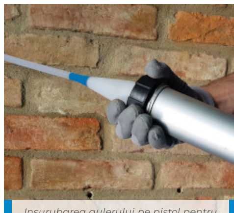
Insurubarea gulerului pe pistol pentru fixarea duzei de injectare
