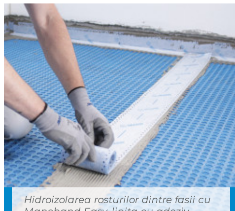
Instalarea Mapeguard UM 35
