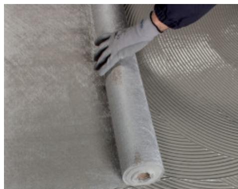
Inglobarea Mapenet Sel N in primul strat de Mapelastich Turbo in stare umeda
