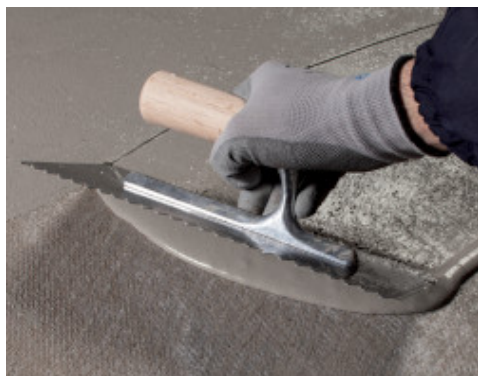
Al doilea strat de Mapelastich Turbo peste primul strat intarit cu Mapetex Sel N
