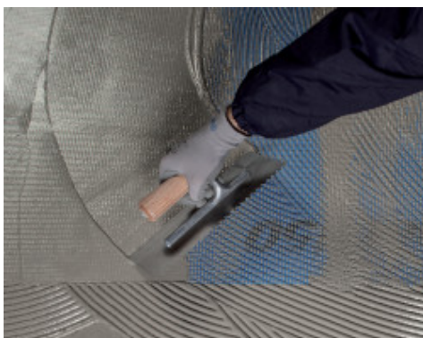
Inglobarea Mapenet 150 in primul strat de Mapelastich Turbo in stare umeda
