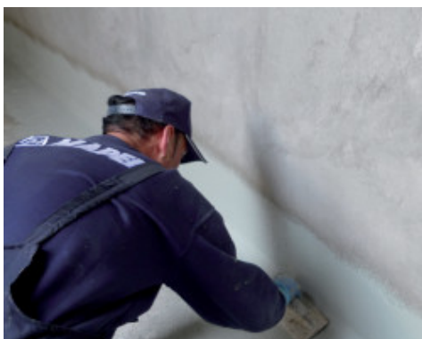
Mapelastic Foundation se întinde cu mistria pentru a impermeabiliza împotriva apei în presiune negativă
