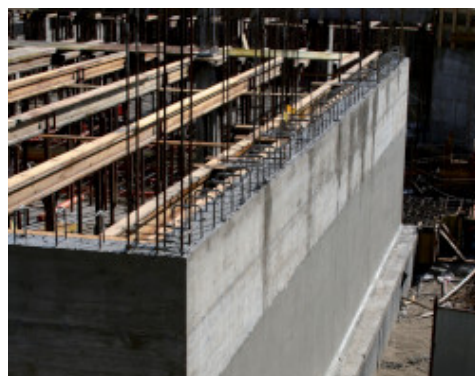
Zid de sustinere impermeabilizat dupa turnare folosind Mapelastic Foundation
