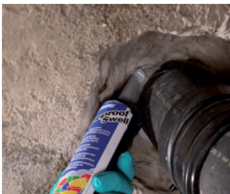
Element de trecere sigilat cu Mapeproof Swell
