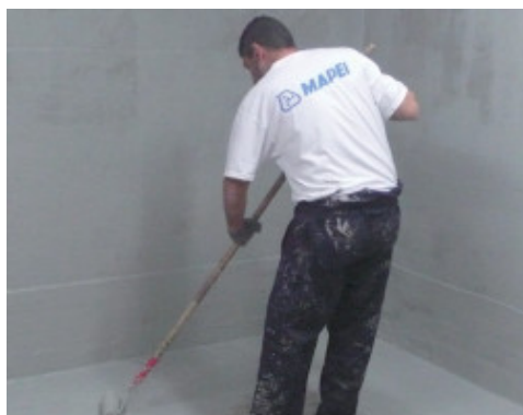
Mapelastic Foundation se întinde cu rola pentru a impermeabiliza împotriva apei în presiune negativă
