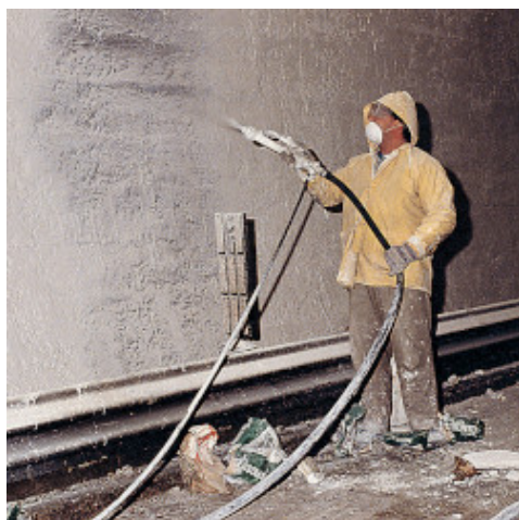
Aplicarea de Planiseal 88 alb prin pulverizare într-un tunel de autostrada
