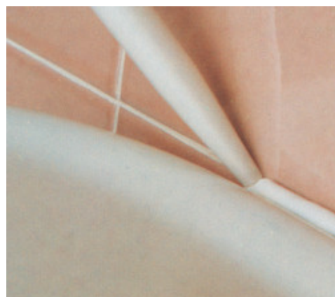
Etansarea corpurilor sanitare
