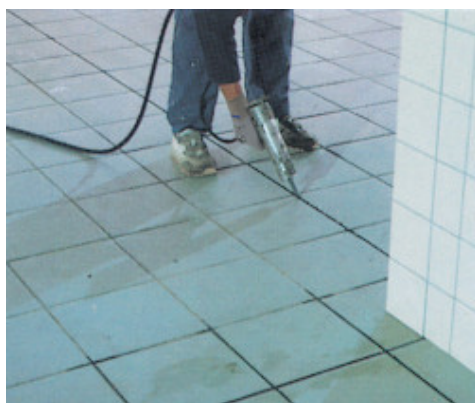
Etansarea unei pardoseli din placi ceramice cu Mapefil AC
