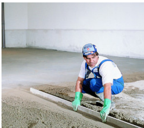
Realizarea fasciilor de ghidaj și nivel
