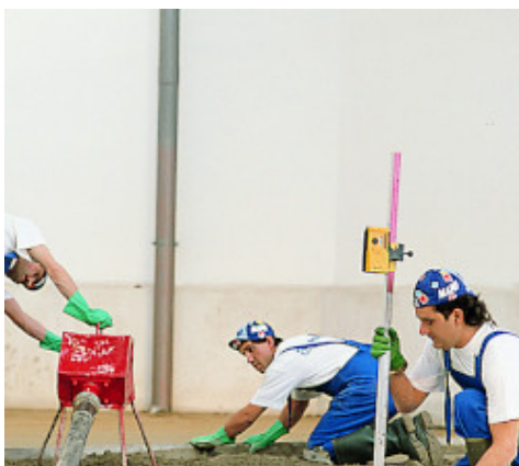
Aplicarea și nivelarea Topcem
